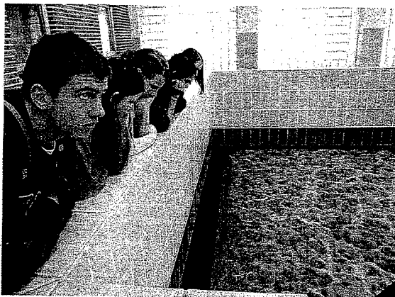
Vor Ort im Wingster Wasserwerk: Eisenspülung am Filterbecken.
